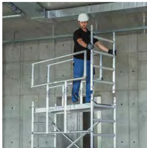
Gesichert durch das „vorlaufende Geländer“, kann die Plattform nun gefahrlos betreten und der weitere Gerüstaufbau fortgesetzt werden. Das Montagesicherungsgeländer wird für folgende Plattformen wieder „vorlaufend“ eingesteckt.
